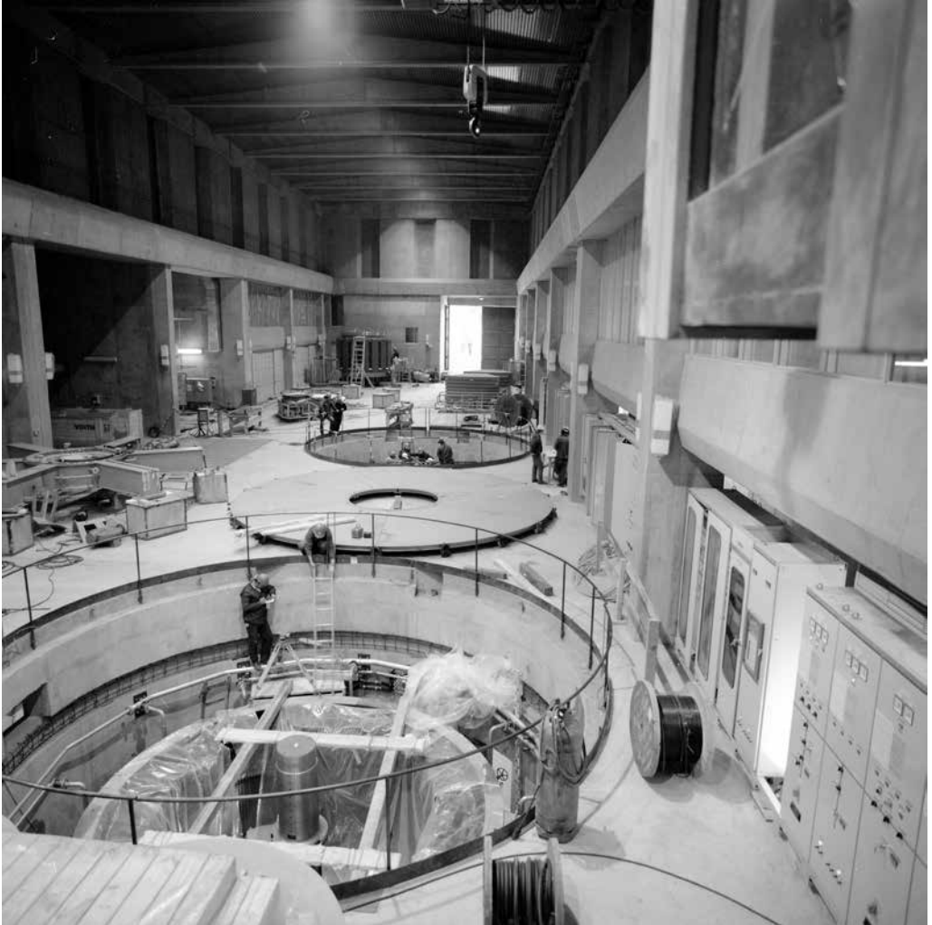
Instalación Tuberías de Planta Hidroeléctrica El Alfalfal, 1990. Fuente: Cámara Chilena de la Construcción
