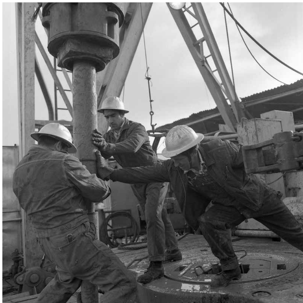
Perforación Petróleo, Enap-Magallanes 1960. Cámara Chilena de la Construcción
