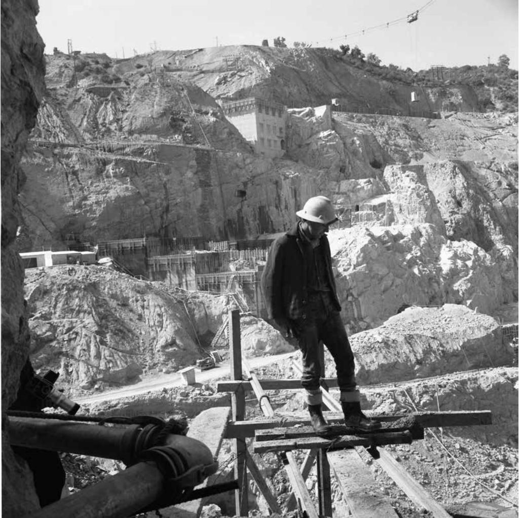
Construcción Central Hidroeléctrica Rapel, 1968. Fuente: Archivo Central Andrés Bello
