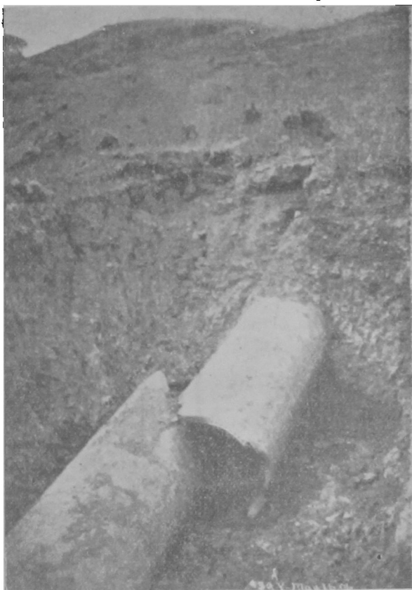
Fig. 22.—Movimiento de telescopiamiento con traslacion lateral i aplastamiento
