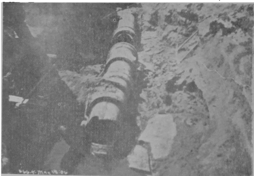
Fig. 27.—Ruptura de cañerías (Esquina de las calles séptima i de Howard)
