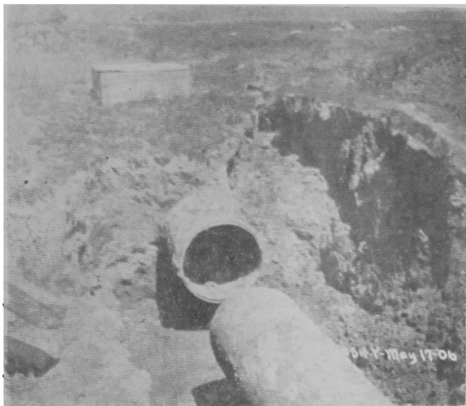
Fig. 19.—Disyuncion simple (de 20 pulgadas
