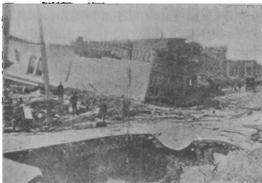
Fig. 25.—Hundimiento con desplome de las casas (Calle décimo-cuarta)
