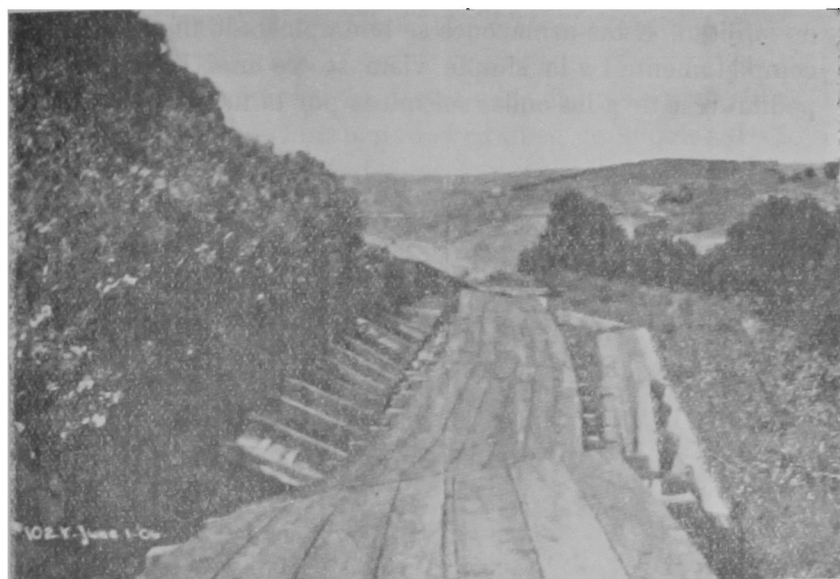
Fig. 16.—Daños a las armazones de las cañerías de San Andres
