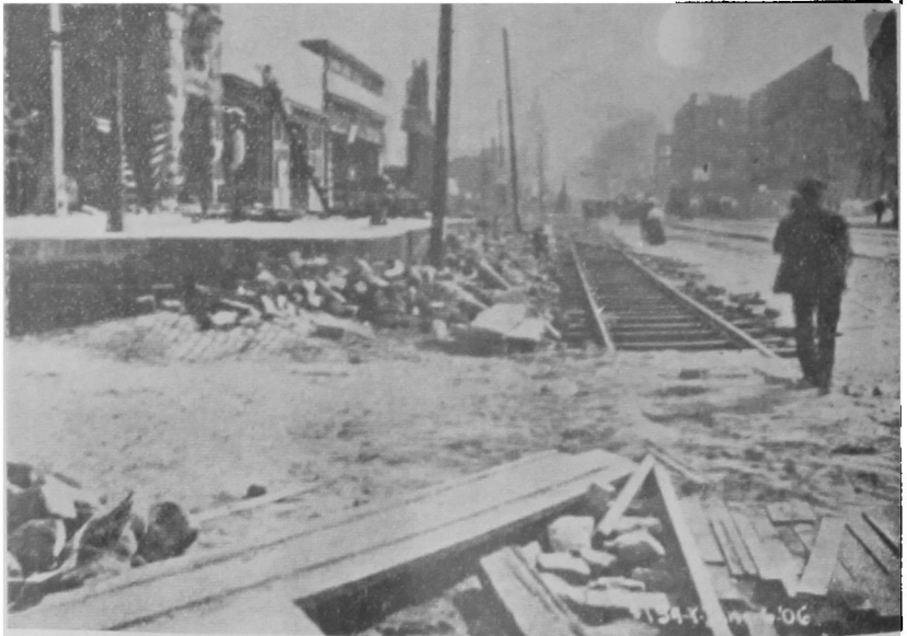
Fig. 24.—Hundimiento sin desplomo de las casas (Calle del Mercado, esquina de la calle de Spear)
