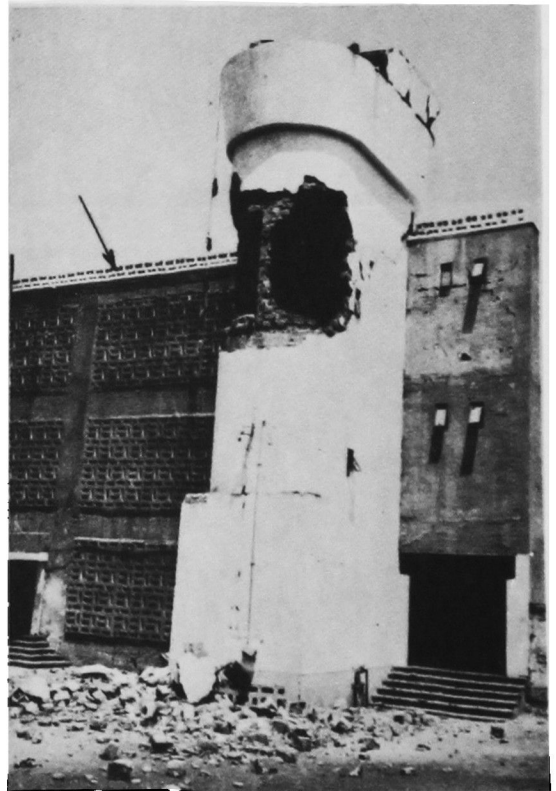
Fig. 30. Caja de escaleras y estanque de agua potable del Liceo Coeducacional.
