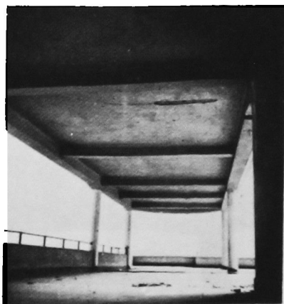
Fig. 21. Marquesina en la terraza del Hospital.
